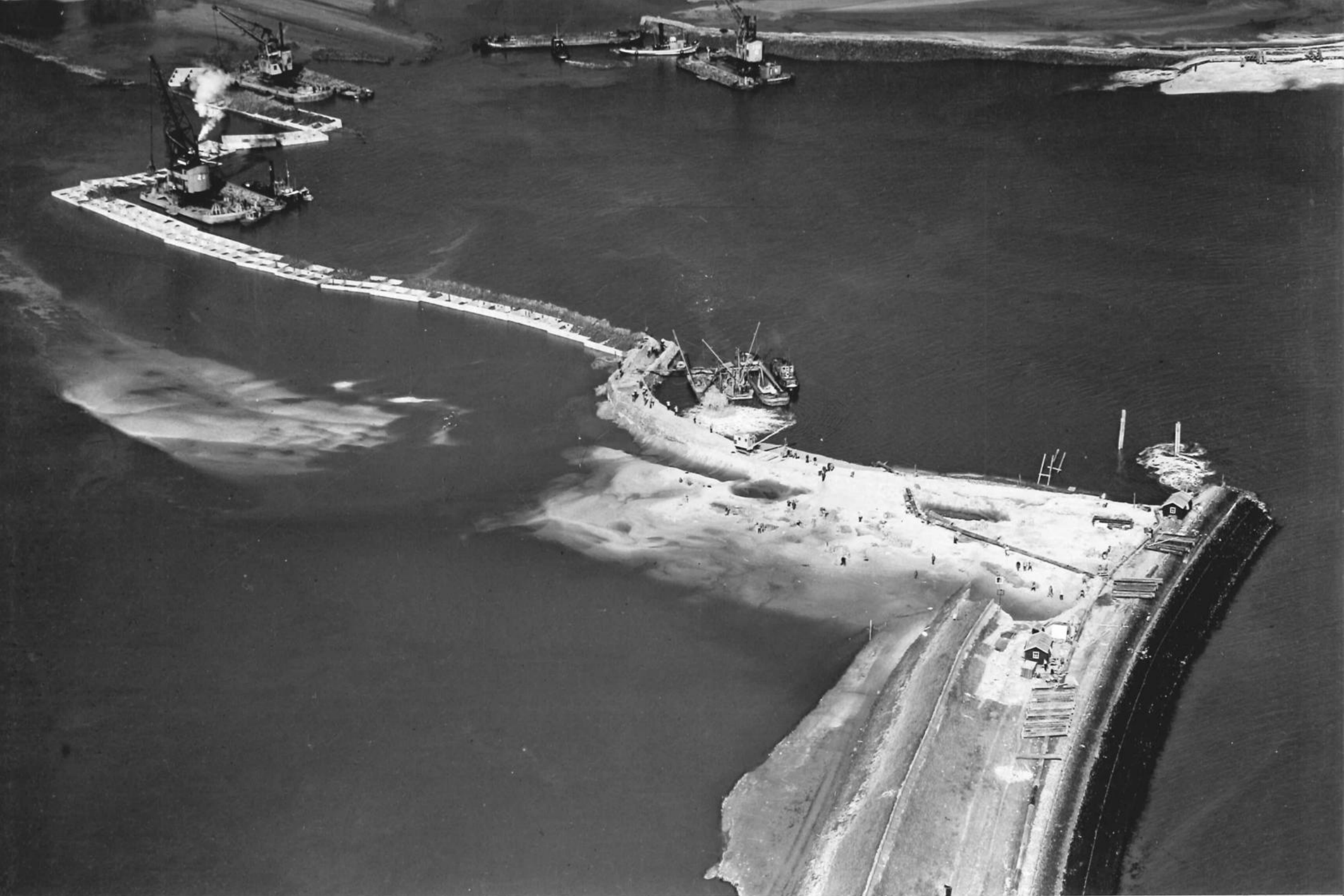
19942 KRUININGEN: Herstelwerkzaamheden dijkdoorbraken — 4 Juni 1953 Foto K.L.M.
