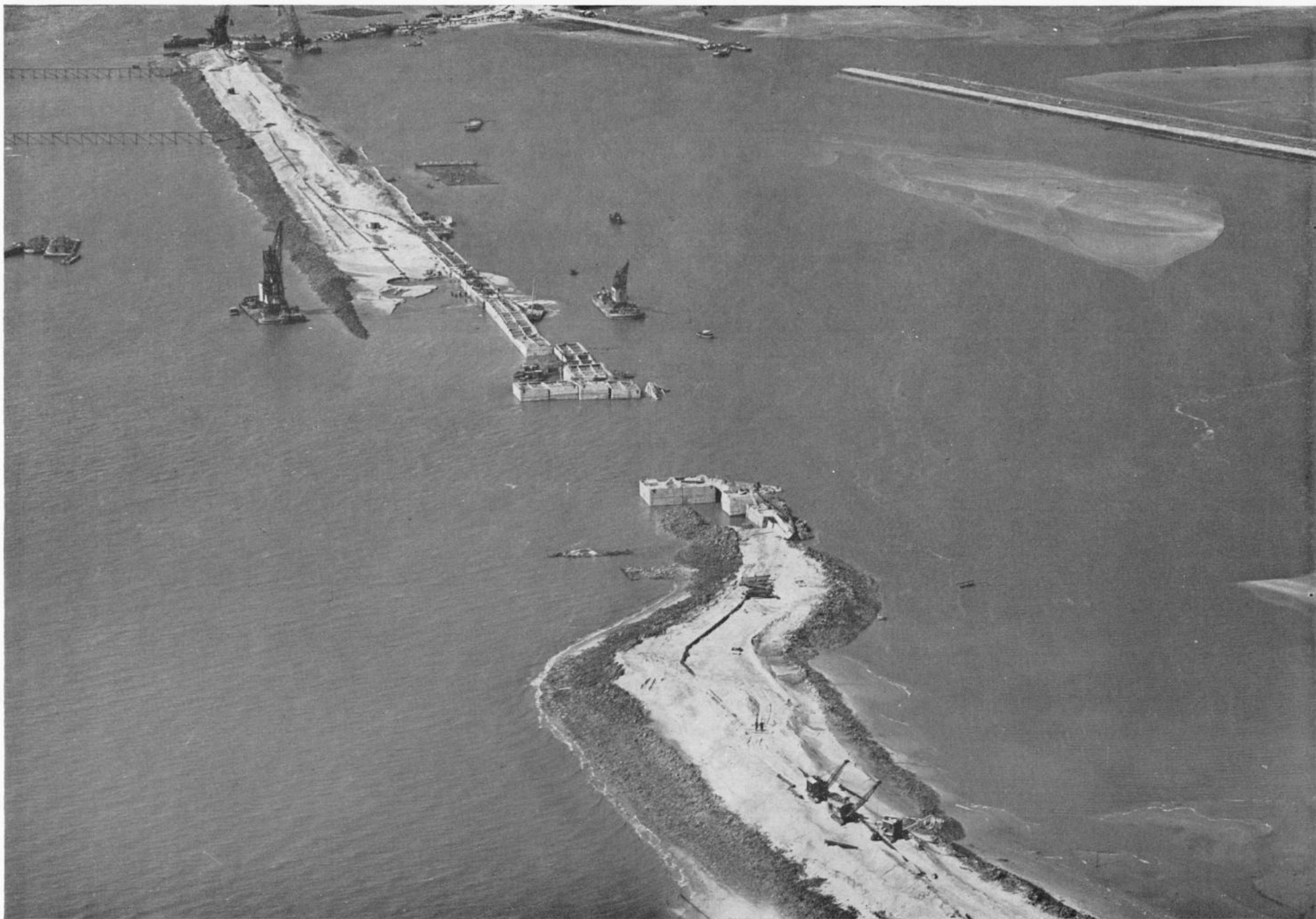
Ouwerkerk, oostelijk gat Boven: westelijk gat
