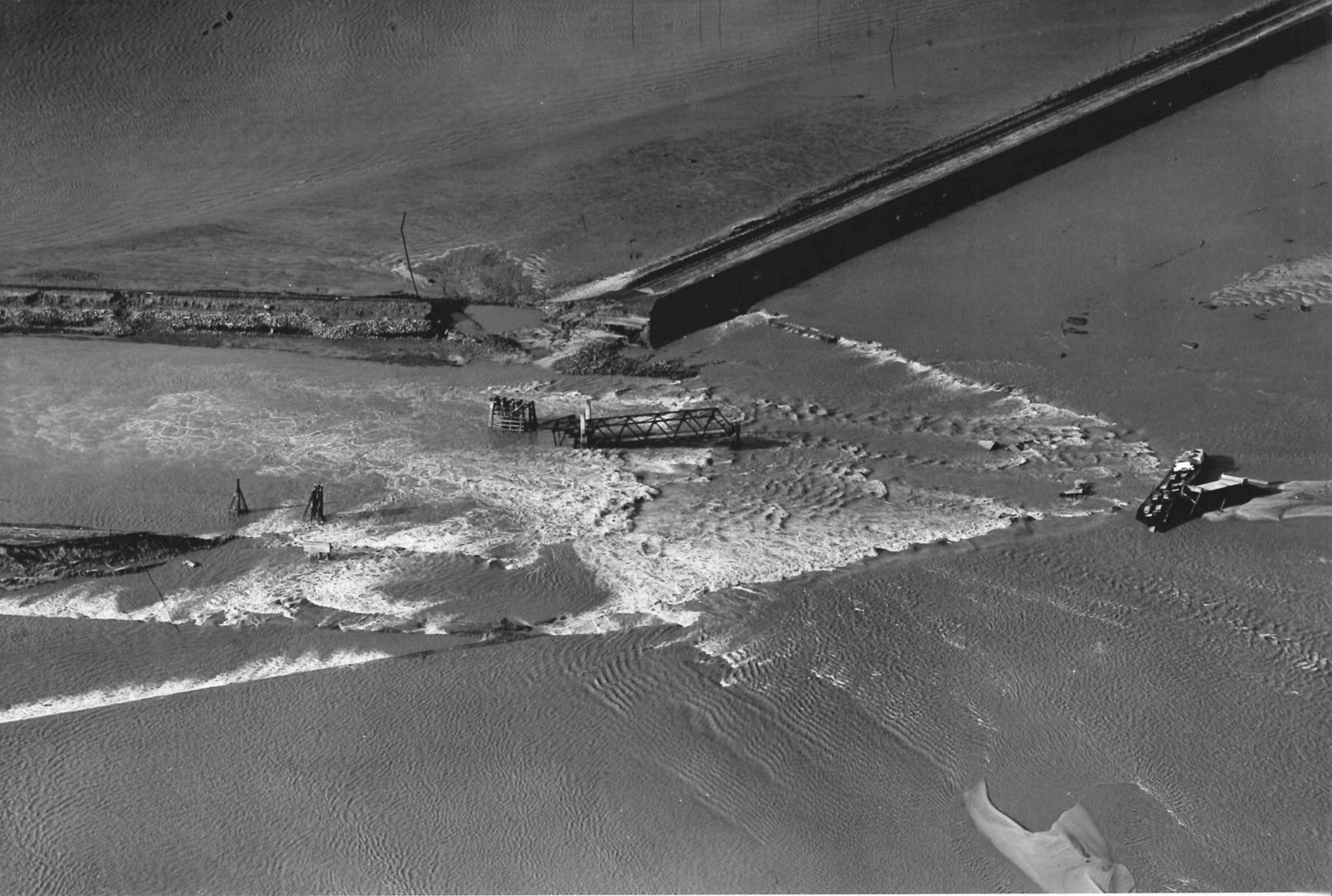
19544 KRUININGEN: Dijkdoorbraak Perkpolder bij de Veerhaven — 2 Februari 1953 Foto K.L.M.
