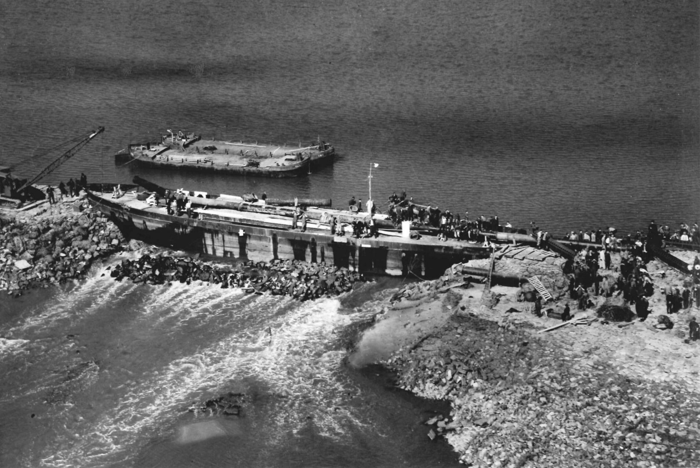
19818 RILLAND-BATH: Herstelwerkzaamheden dijkdoorbraken — 21 April 1953 Foto K.L.M.
