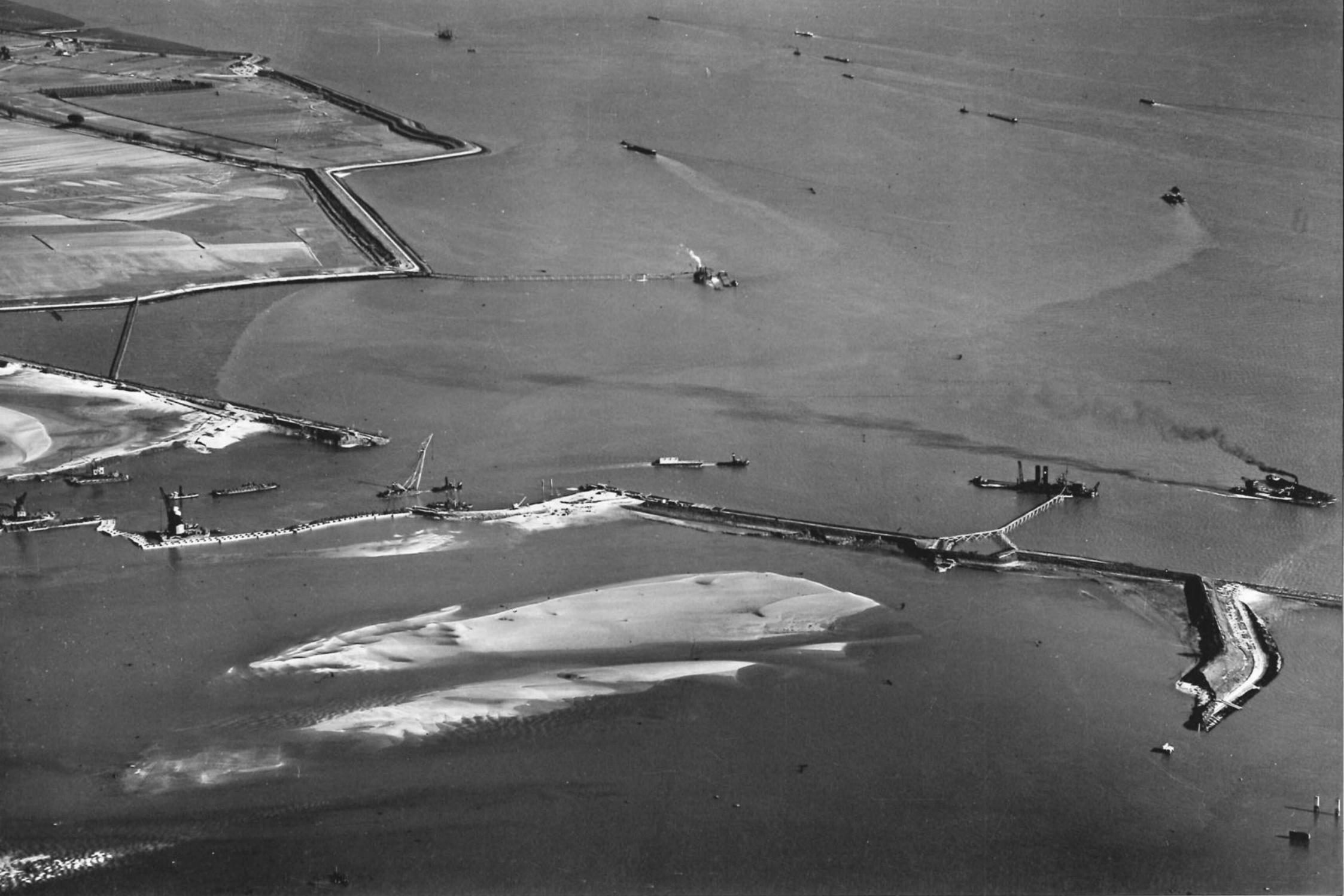
19947 KRUININGEN: Herstelwerkzaamheden dijkdoorbraken — 4 Juni 1953 Foto K.L.M.
