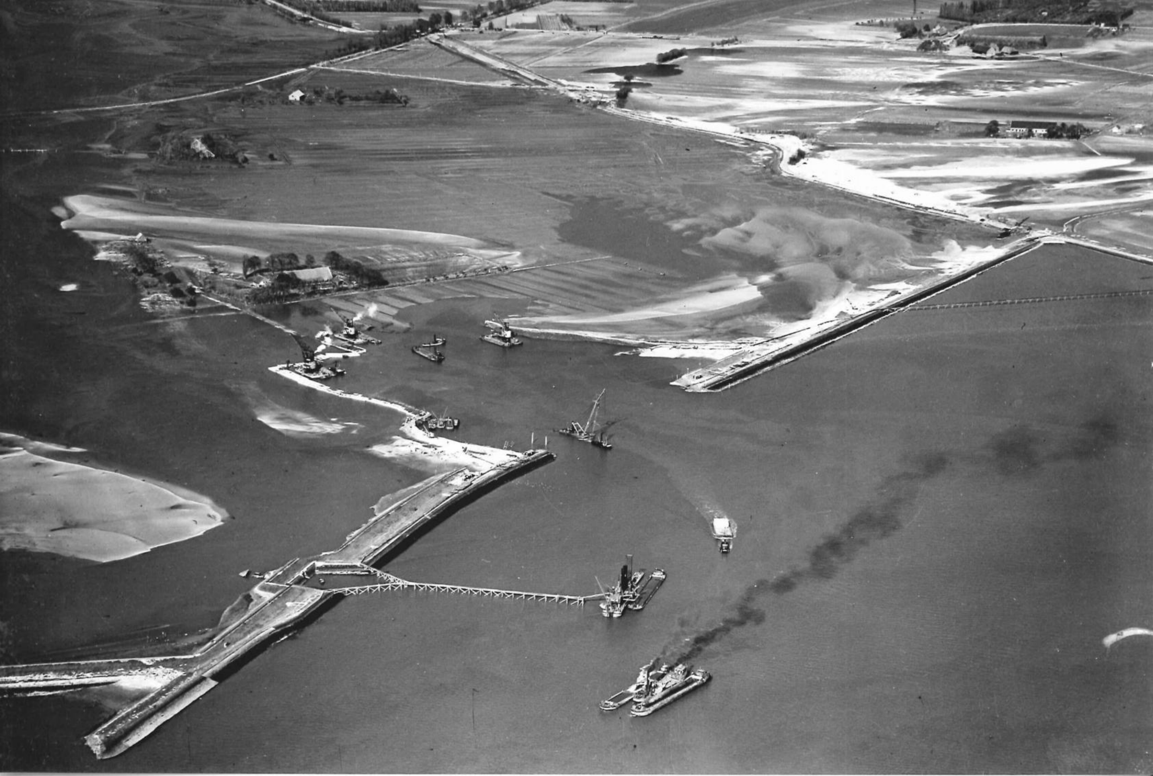
19951 KRUININGEN: Herstelwerkzaamheden dijkdoorbraken — 4 Juni 1953 Foto K.L.M.
