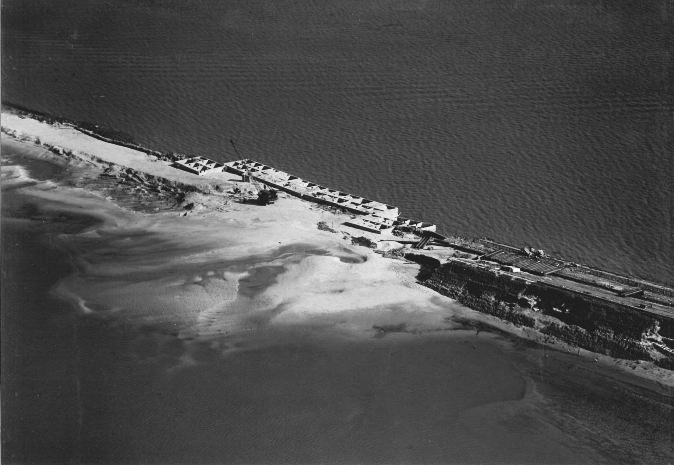
19953 KRUININGEN: Herstelwerkzaamheden dijkdoorbraken — 4 Juni 1953 Foto K.L.M.
