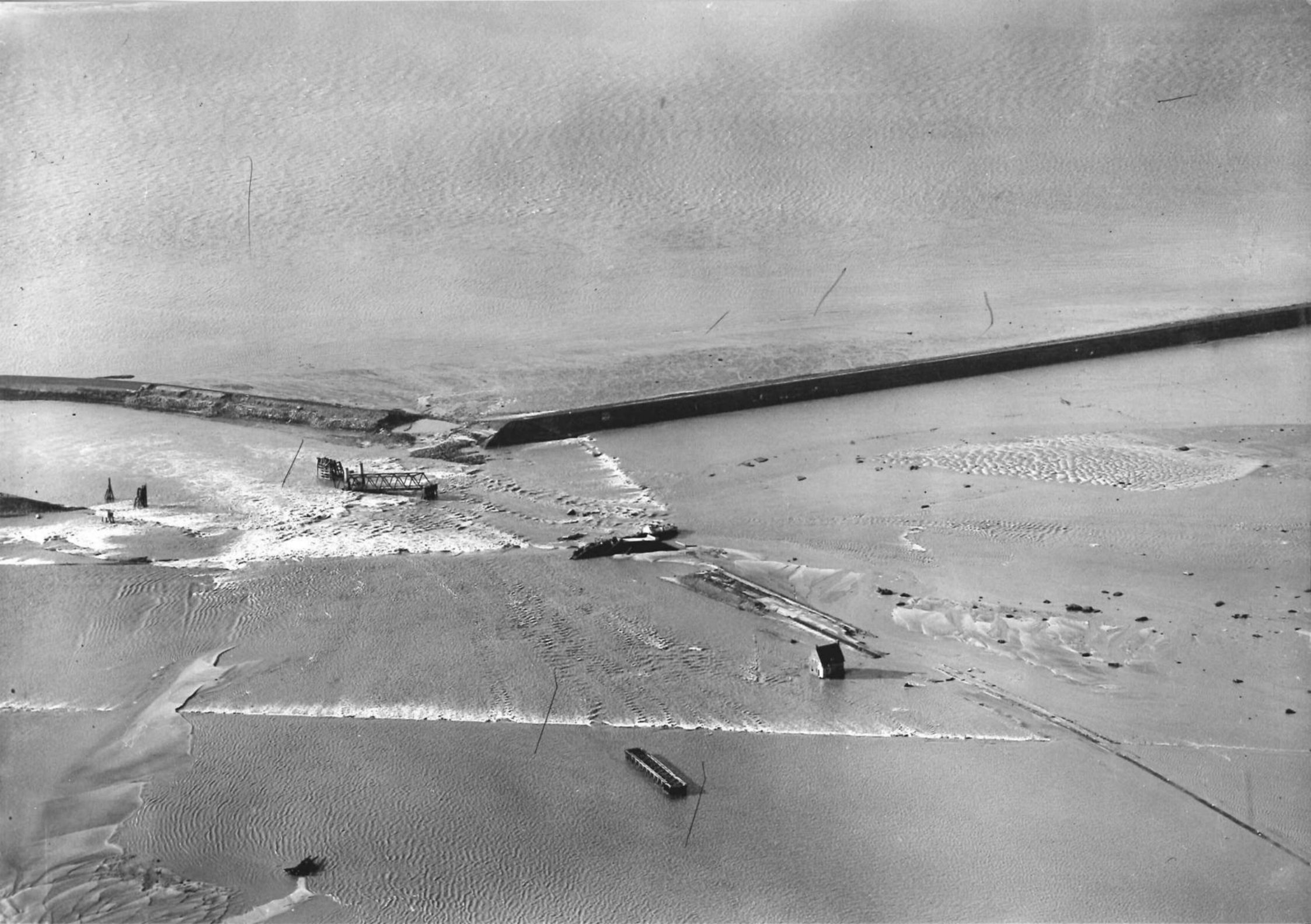
19545 KRUININGEN: Dijkdoorbraak Perkpolder bij de Veerhaven — 2 Februari 1953 Foto K.L.M.
