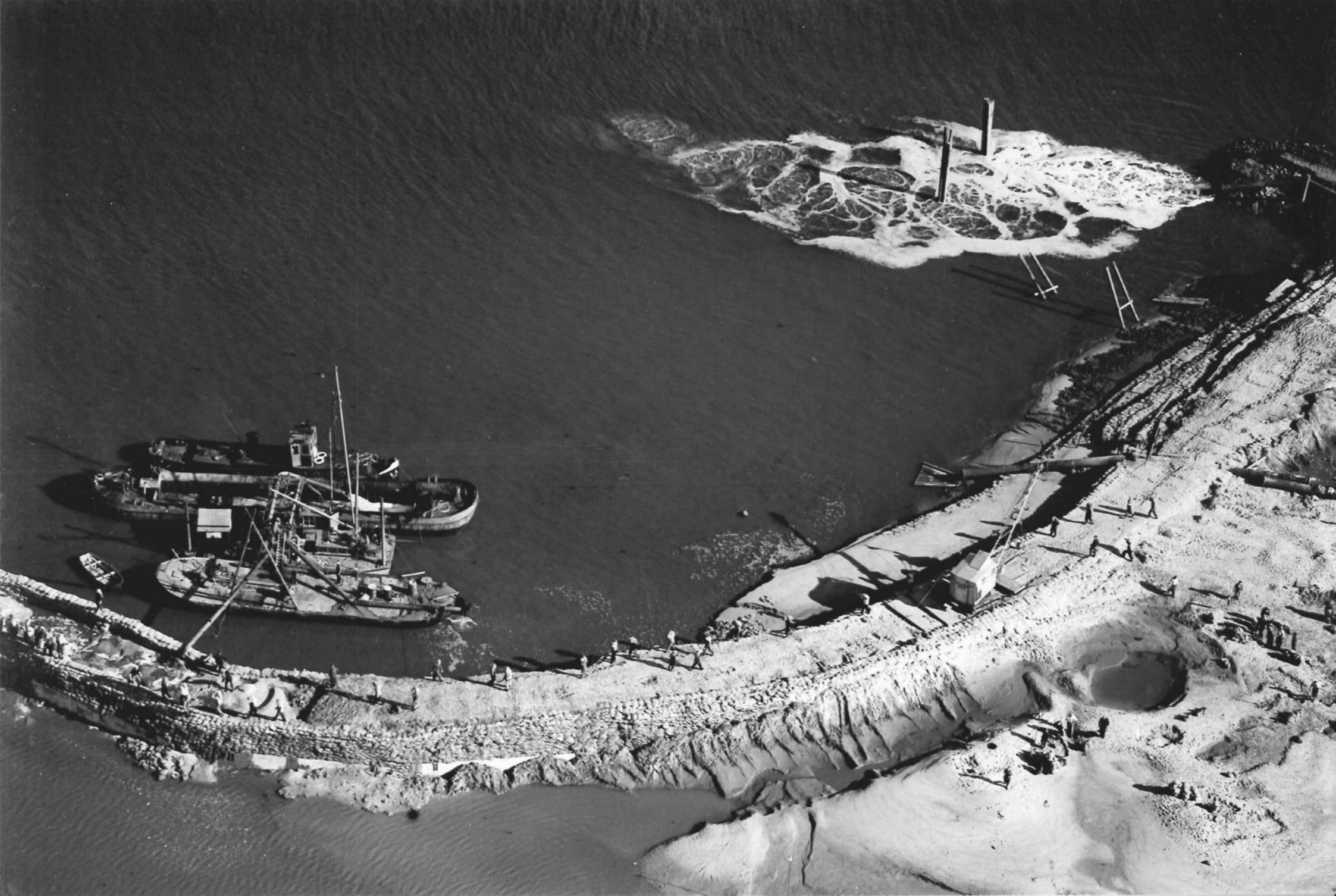
19955 KRUININGEN: Herstelwerkzaamheden dijkdoorbraken — 4 Juni 1953 Foto K.L.M.
