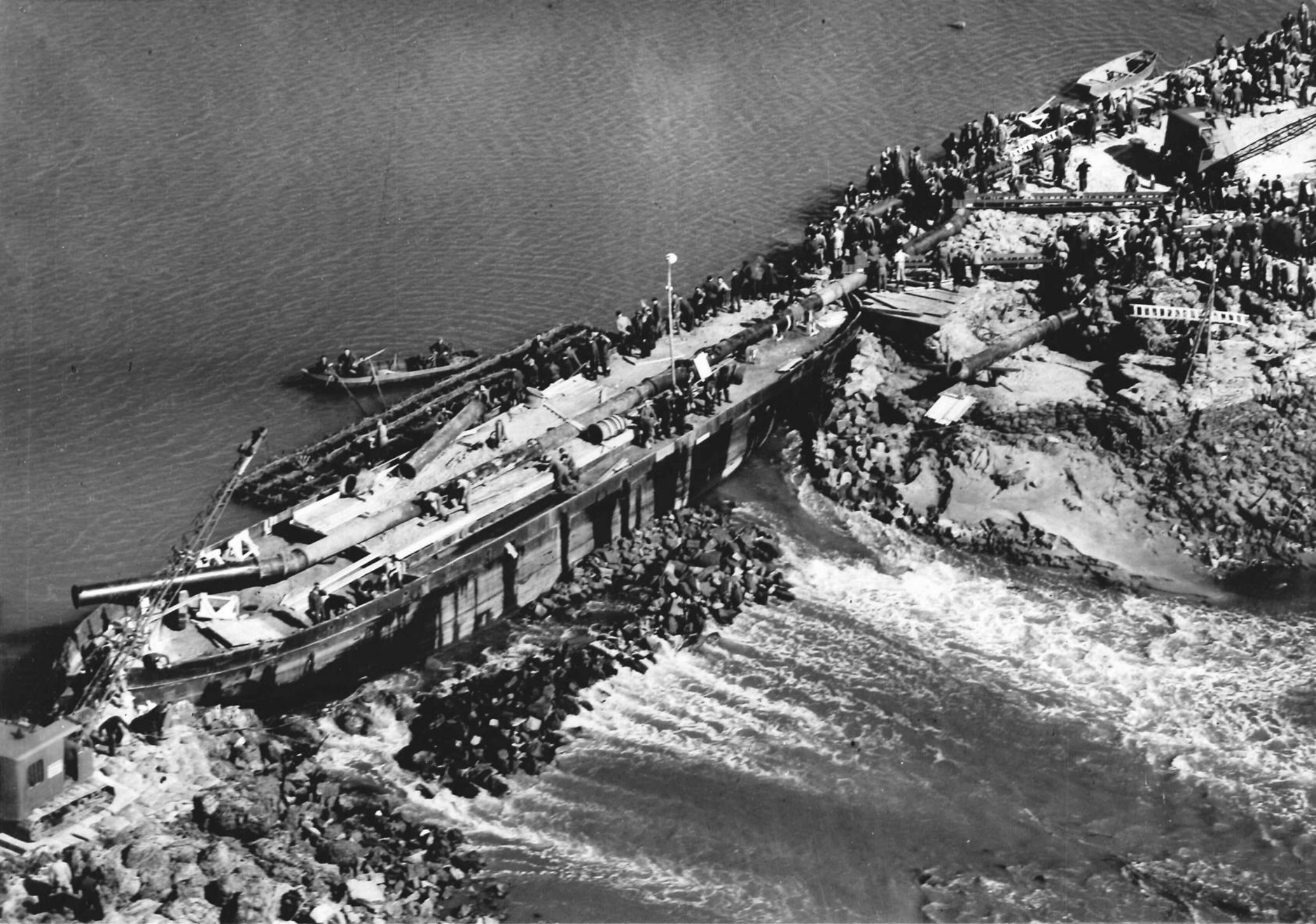
19817 RILLAND-BATH: Herstelwerkzaamheden dijkdoorbraken — 21 April 1953 Foto K.L.M.
