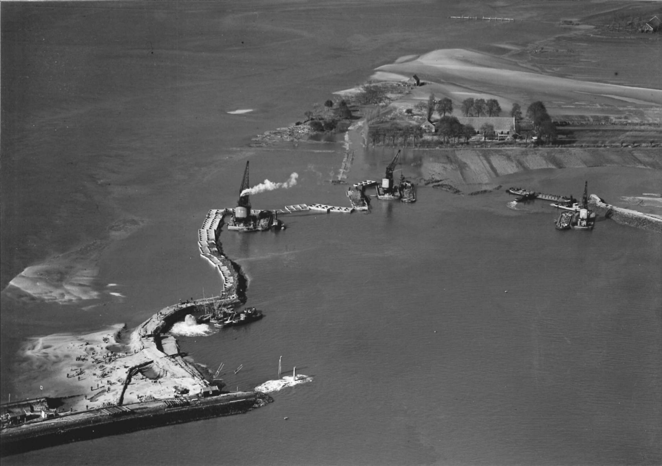
19943 KRUININGEN: Herstelwerkzaamheden dijkdoorbraken — 4 Juni 1953 Foto K.L.M.
