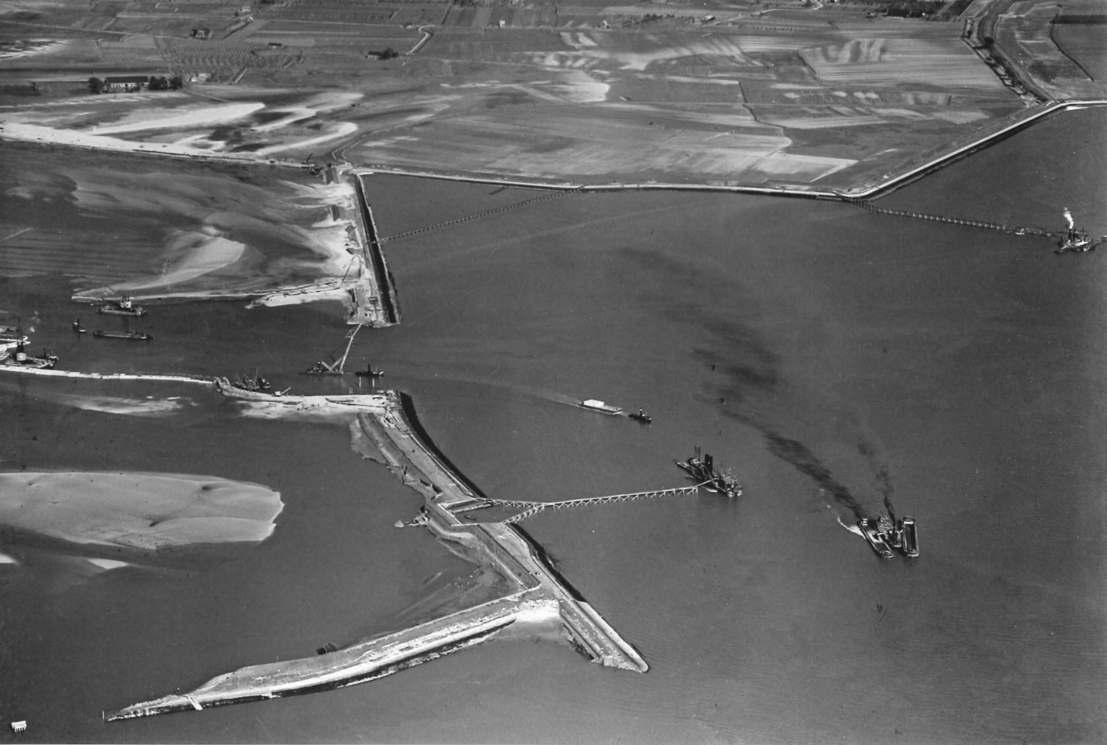
19952 KRUININGEN: Herstelwerkzaamheden dijkdoorbraken — 4 Juni 1953 Foto K.L.M.
