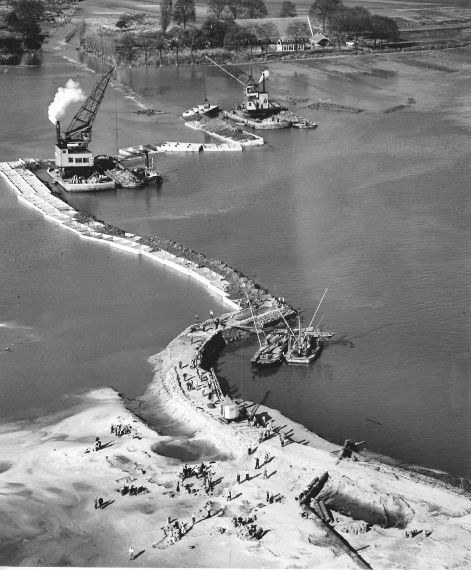
19939 KRUININGEN: Herstelwerkzaamheden dijkdoorbraken — 4 Juni 1953 Foto K.L.M.
