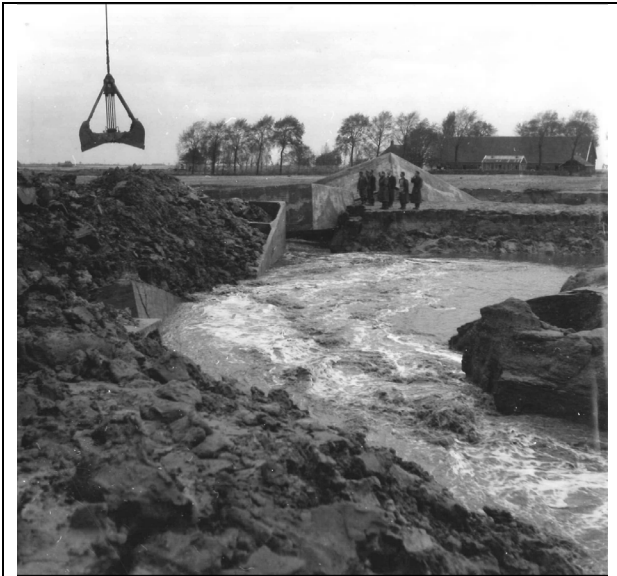
Sluiting met de bodemloze caissons
