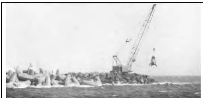
Bouw van de golfbreker van Sines met grote Dolosse
