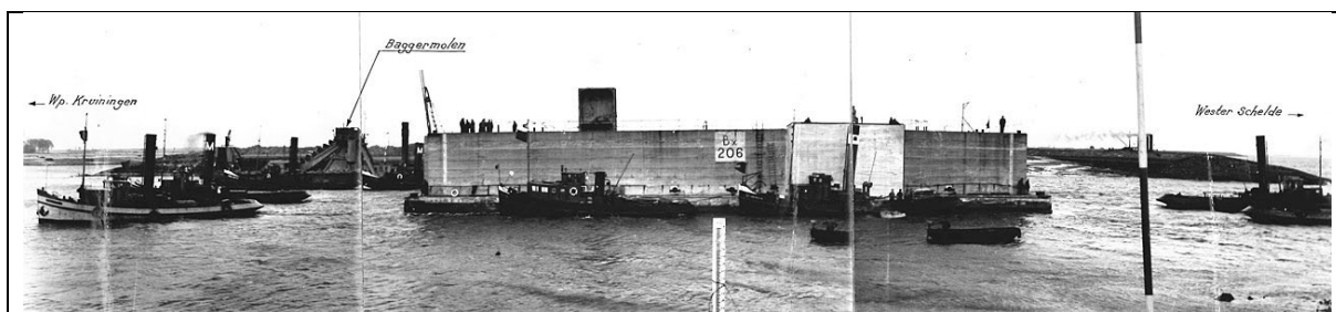
Caissonsluiting bij Kruiningen o.l.v. Jan Agema
