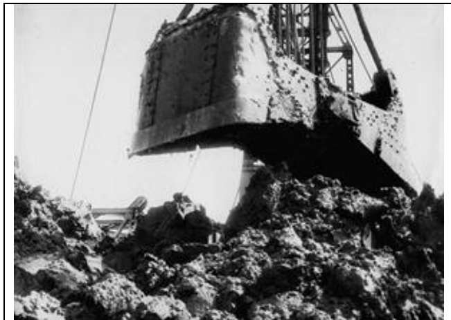
Het gebruik van keileem bij de Afsluitdijk
